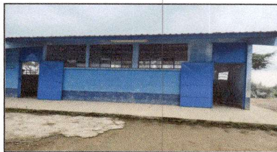
FOTO 6: Reparación de planchas de concreto de patio
