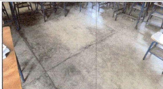
FOTO 2: Sustrucción de piso de cemento liquido por piso ceramico
