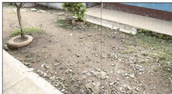
FOTO 4: Reparación de planchas de concreto de patio
